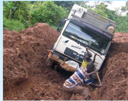
Der „Expressway“ in Kamerun verwandelt sich in der Regenzeit in eine Schlammhöhle. Ohne tatkräftige Hilfe von Einheimischen geht nichts.
